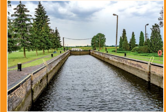
Śluza w Lipicy Schleuse in Lipica
