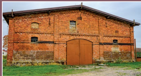
Zabudowania dawnego folwarku w Gądku Vorwerks Gebäuden in Gut Arnsmühl
