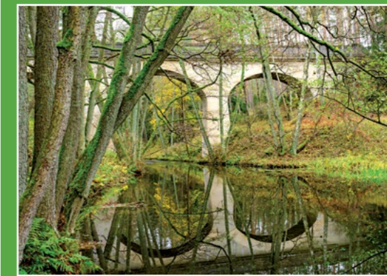
Most kolejowy na Rurzycy Eisenbahnbrücke auf der Rohra
