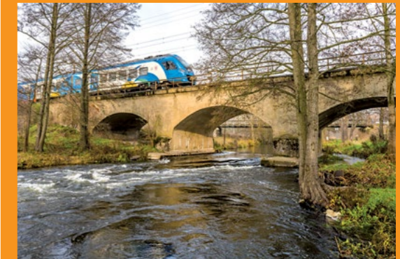
Most kolejowy w Łokaczu Wielkim Eisenbahnbrücke in Lukatz
