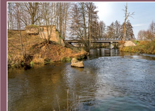
Most przez Drawę w Bielicach Nowych Drage Brücke in Neu Beelitz
