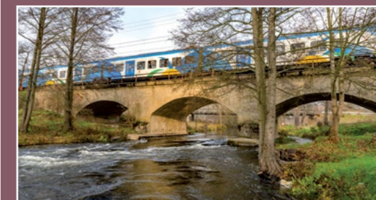
Most kolejowy przez Drawę Eisenbahnbrücke auf der Drage
