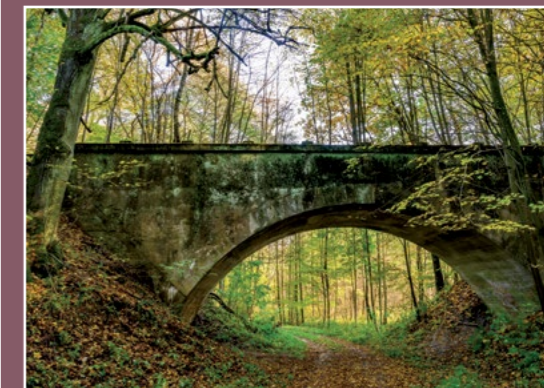
Most kolejowy w Żelichowie Eisenbahnbrücke in Selchow
