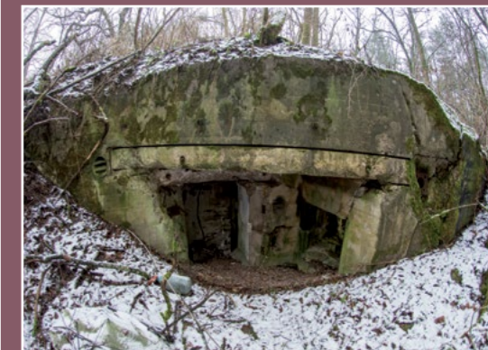
Bunkier koło Bielich Nowych Bunker bei Neu Beelitz
