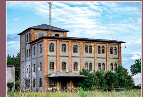
Dawny młyn w Hucie Szklanej Ehemalige Mühle in Glashütte
