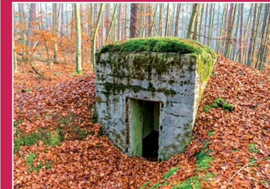
Bunkier na Wale Pomorskim Bunker in der Pommernstellung
