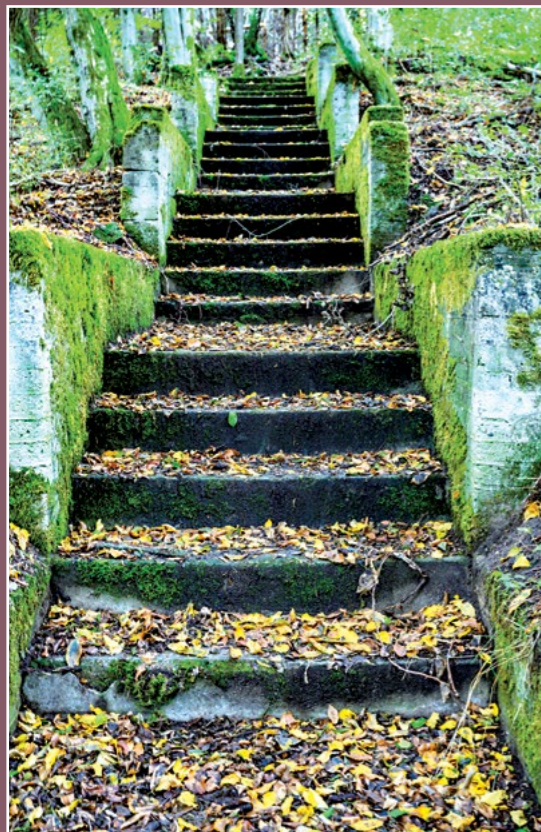
Schody do zburzonego pałacu w Zaciszu Treppe zum gestörten Palast in Prosekelmühle
