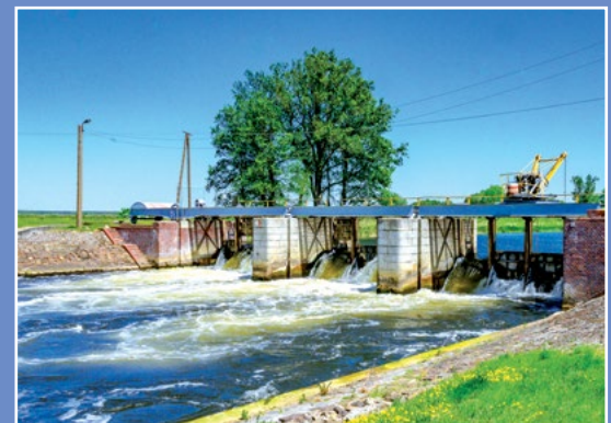
Jaz na Noteci Stauwehr an der Netze
