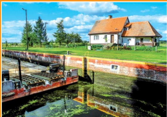
Noteca śluza Netzeschleuse
