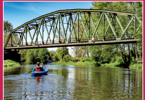
Most kolejowy w Ujściu Eisenbahnbrücke in Usch
