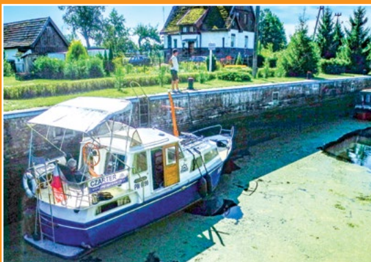
Śluza Romanowo Schleuse in Romanowo
